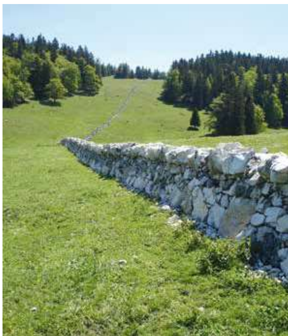
Grâce au soutien du FSP, le Parc Jura vaudois a pu restaurer plus de douze kilomètres de murs en pierres sèches entre 2010 et 2017.
