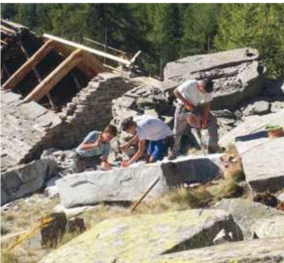
Giovani operai al lavoro per ristrutturare le cascine di Corte Grande
