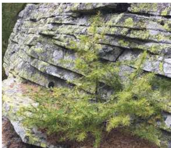
Lastré di pietra e un piccolo larice: ecco il materiale a chilometro zero usato per i lavori di restauro
