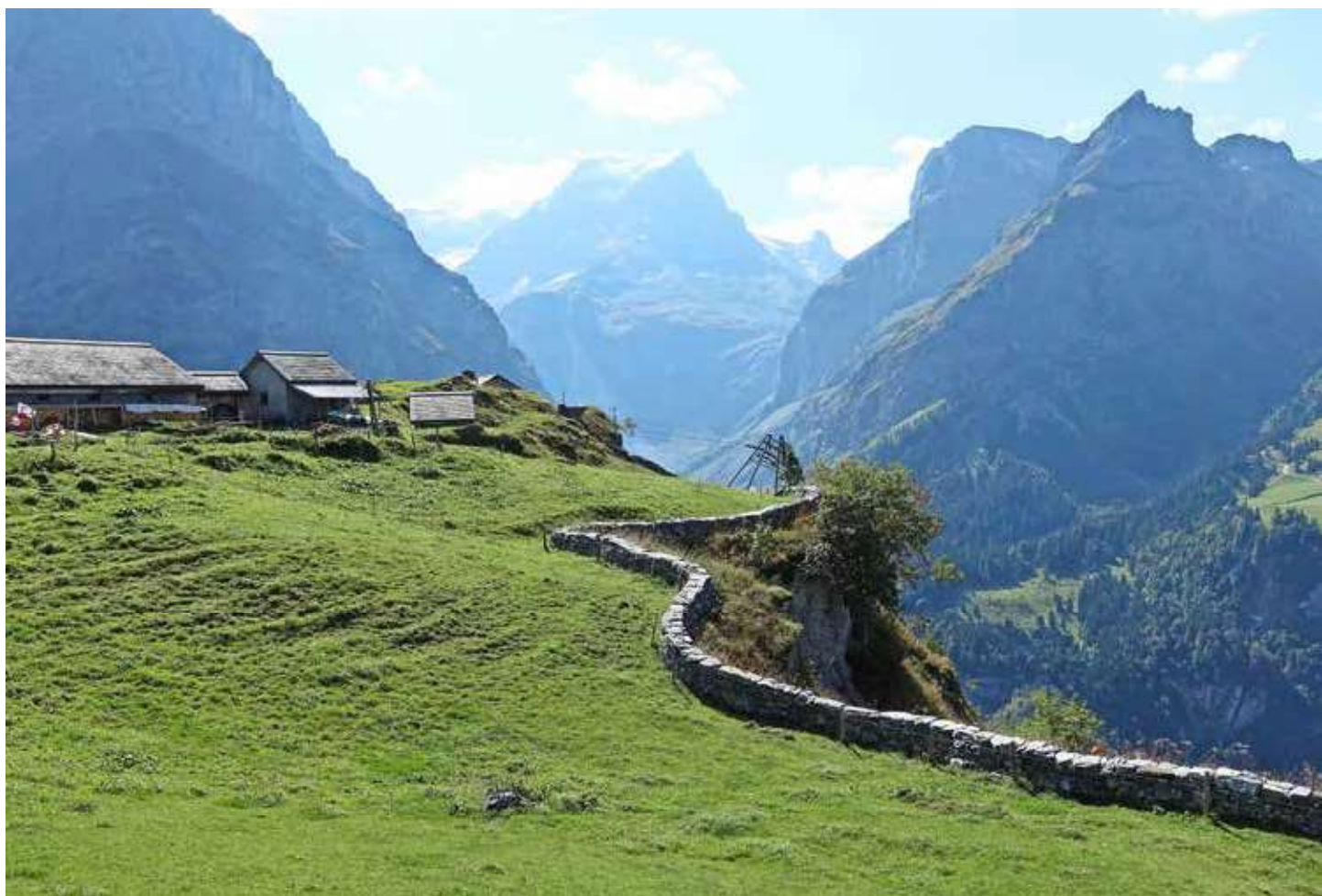
Direkt an der Kante bewahrt die Trockenmauer Tier und Mensch vor dem Absturz.
