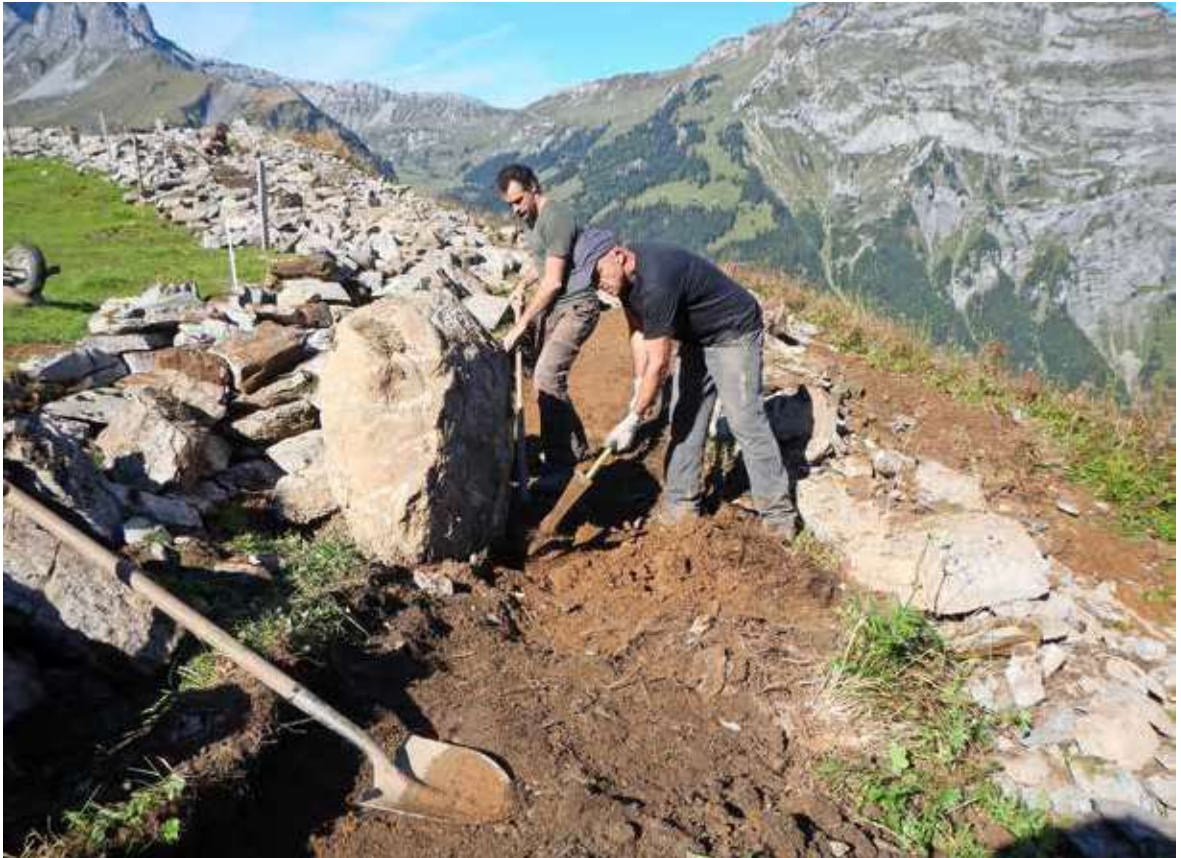
Die Restaurationsarbeiten sind anstrengend und aufwändig.
