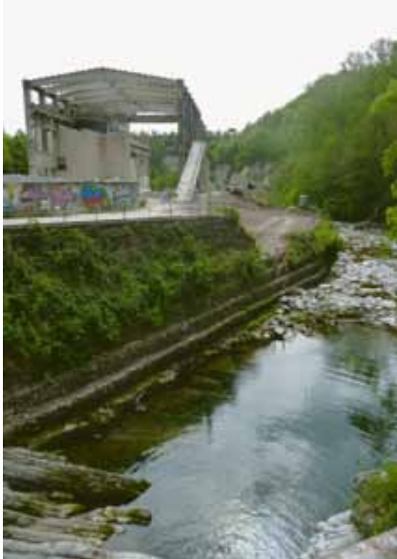
Überreste der Zementfabrik Saceba
